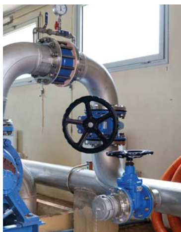
Travaux sur le réseau eau et assainissement (170 millions en 15 ans)
